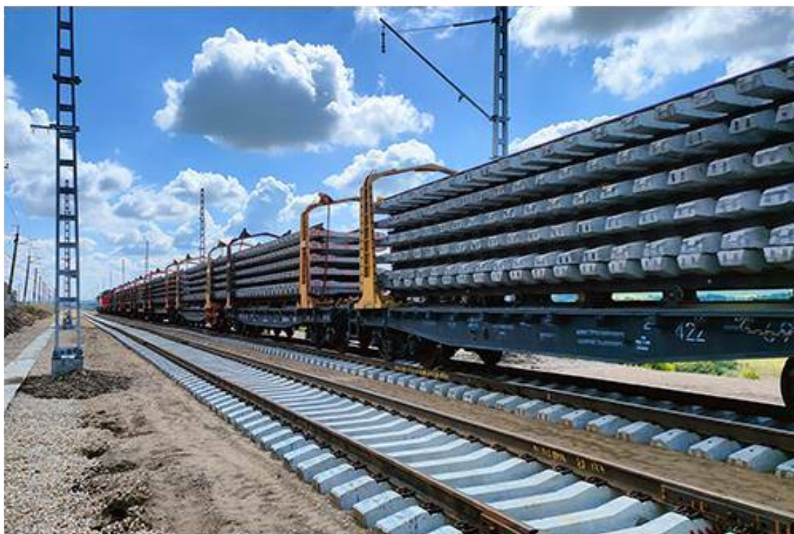
Рисунок – 4 Строительство новой двухпутной железнодорожной линии
